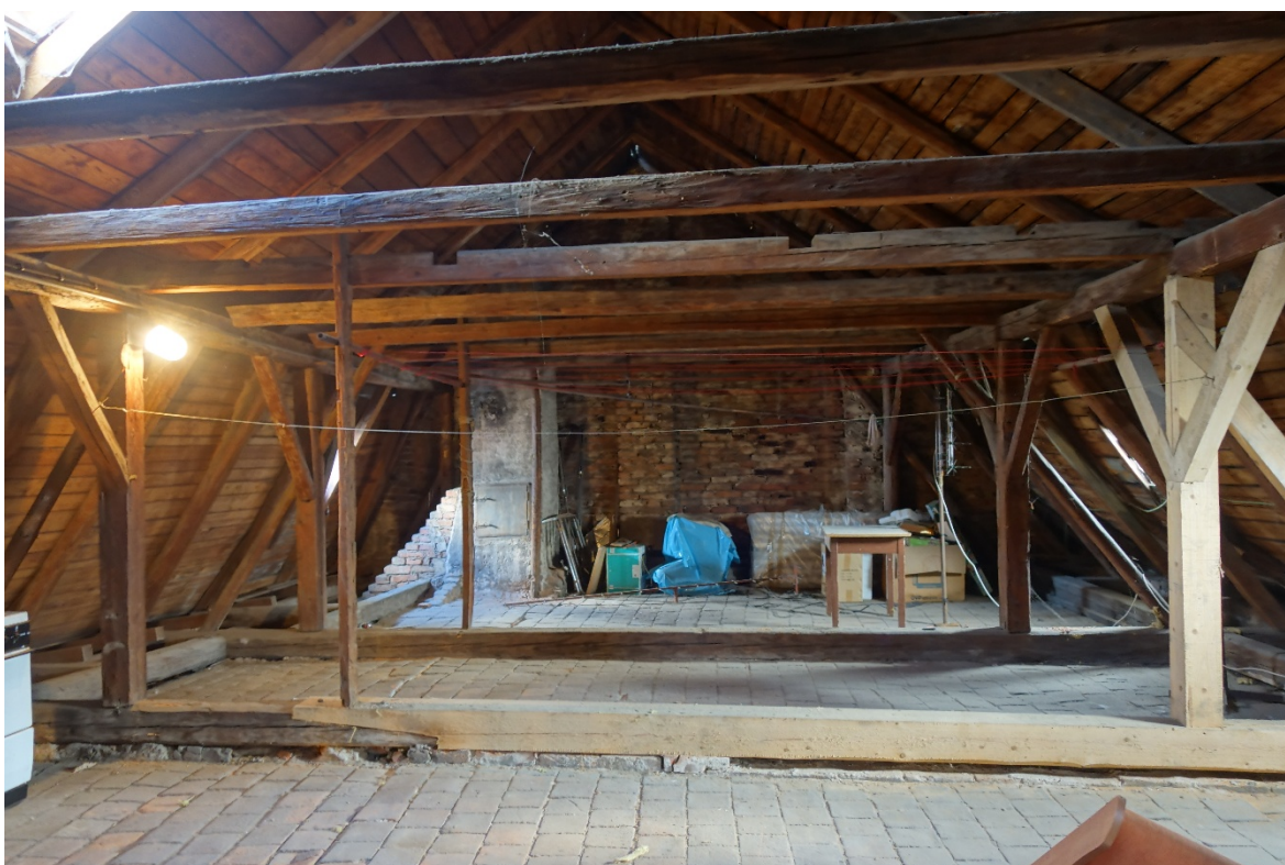
Pohledy na konstrukci mansardového krovu datovaného do let 1829/1830, fotoarchiv NPÚ, ÚOP v Telči, 9. 11. 2021
